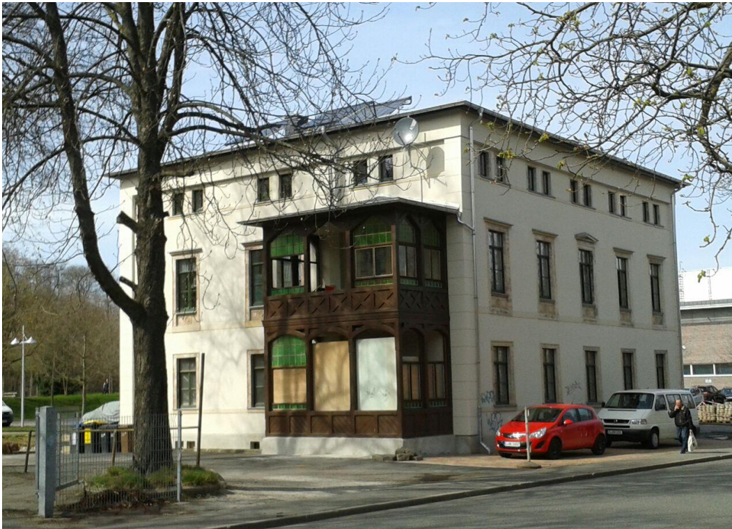
Villa Schwalbe (eigene Aufnahme)
